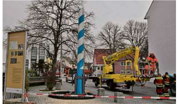
Der Maibaum in Manching musste aus Sicherheitsgründen entfernt werden.
