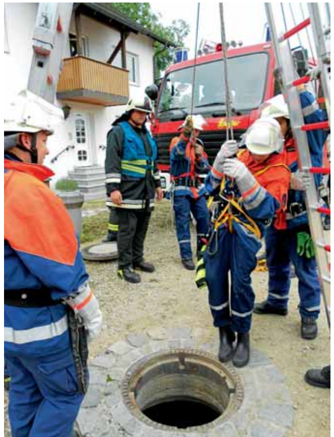
Einstieg in den Kanal.
