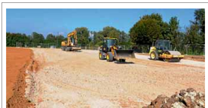
Mit Beginn der Erdarbeiten Mitte September 2011 begannen die Bauarbeiten zur neuen Kindertagesstätte im Lindenkreuz. Die Bodenplatte mit Kanalarbeiten wird in den nächsten Wochen erstellt. Markt Manching (StM) / Foto: Max Schmidtner
