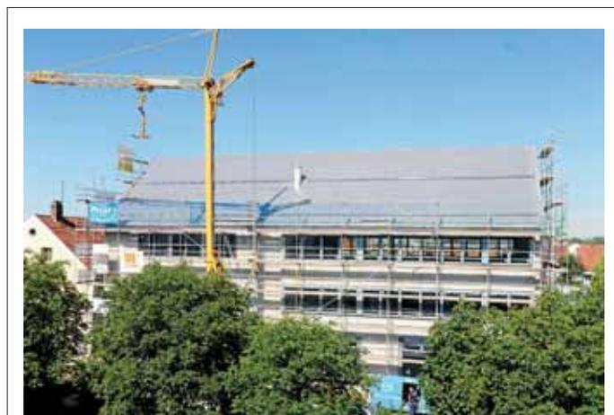
**Das Dach der neuen Bibliothek ist nunmehr fertig gestellt und es wurde mit den Arbeiten zum Anbringen des Vollwärmeschutzes begonnen. Gleichzeitig erfolgt der Innenausbau der Bibliothek (Heizung, Sanitär, Lüftung, Elektro).** Markt Manching (FoJ)
