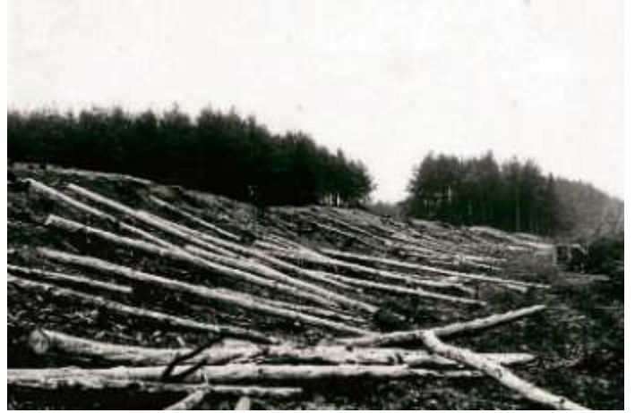
Rodungsarbeiten am Keltenwall von Manching im Rahmen des Flugplatzbaus im Jahr 1938. Bayerisches Landesamt für Denkmalpflege
