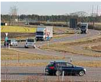
Neubau eines Beschleunigungsstreifens von Manching Süd auf die B 16 in Richtung Regensburg
